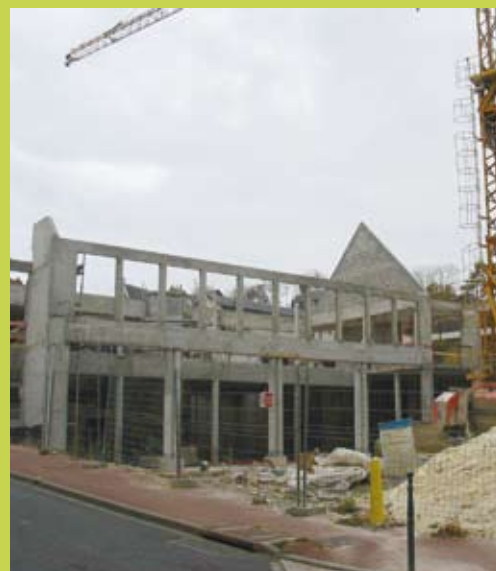
Le gros œuvre de l'espace culturel en cours de finition.
