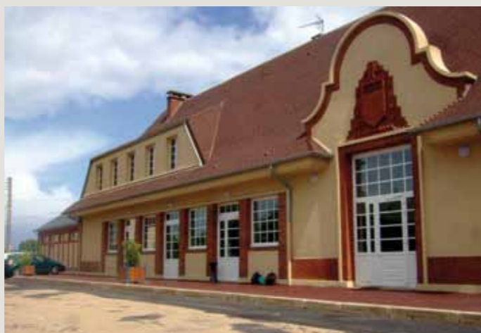
La gare rénovée
