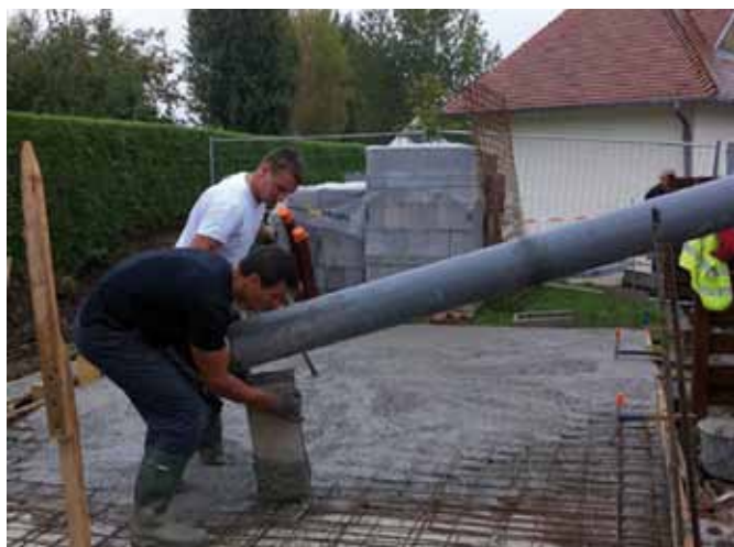
La construction d'un central destiné à la fibre optique
