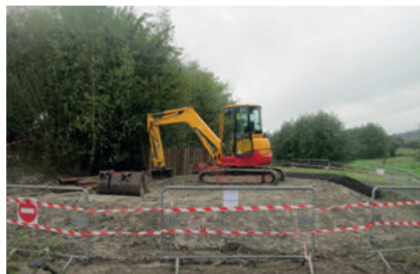
▲ Ci-dessus : Les services techniques lors du terrassement de la motte castrale.
