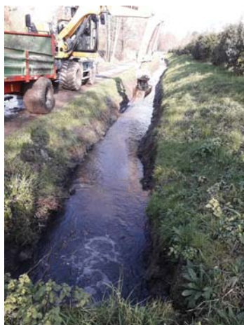
Pendant les travaux
